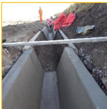
Se visualiza los trabajos del vaciado del canal del concreto de la obra de riego (obra por contrata) comunidad de Phausire distrito de Coporaque, Provincia de Espinar.
