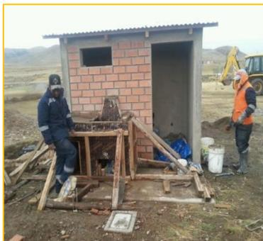
Encofrado de lavaderos de concreto
