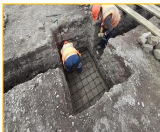
COLOCACIÓN DE PARRILLAS DE ACERO PARA ZAPATAS
