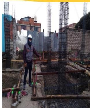
Armado de acero en zapatas, vigas de cimentación y columnas.
