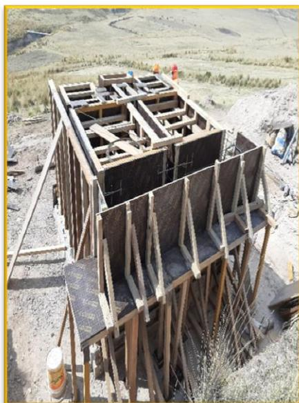
Encofrado de Filtro Lento del Sistema de Red de Agua Potable.
