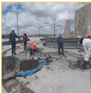
Se viene realizando el control de los niveles y pendientes de los trabajos de enchapado de piedra talamoye en pisos al contorno de la pileta central según los detalles de los planos del expediente técnico aprobado y reformulado
