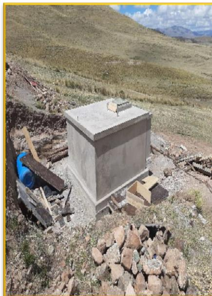
Tarrajeo de Reservorio de Almacenamiento del Sistema de Agua Potable.
