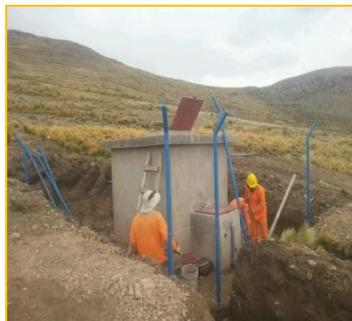
Vaciado de concreto en cimentación cercos perimétricos
