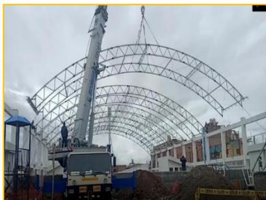
SE VERIFICA LAS ACTIVIDADES COLOCADO DE PLANCHA DE ACERO A36 E=5/8" (1.20MX2-40M) EN LOS BASES DE LOS TJERALES
