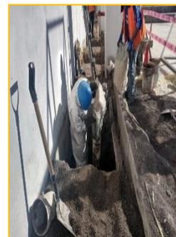
SE REALIZA VACIADO DE PLACAS: CONCRETO F°C=210KG/
