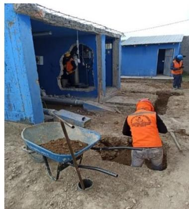
Demolición de muros de caseta de válvulas reservorio Cruzcunca.
