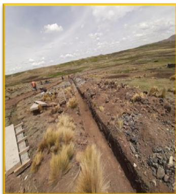
Excavación de terreno para ejecución de rápidas y poza disipadora en Lateral
